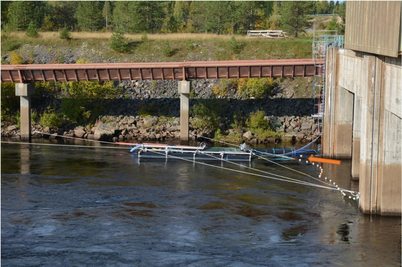
Kuva 2. Kalasydän-vaellusyhteysratkaisu asennettuna Taivalkosken voimalaitoksen alakanavaan. Kuva vuodelta 2019. Laite oli sijoitettu samalla tavalla myös vuonna 2020. Järjestelmän sisäänkäynti on merkitty oranssilla nuolella. Kaloja pyrittiin ohjaamaan kalasydämen sisäänkäyntiin ohjausverkkojen avulla. Kuva: Panu Orell.
