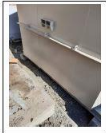
Pyyntilaitteen aukkojen teko kalatiehen ennen altaan liittämistä
