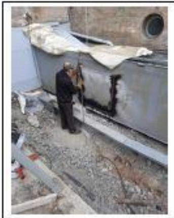
Pyyntilaitteen aukkojen teko kalatiehen ennen altaan liittämistä
