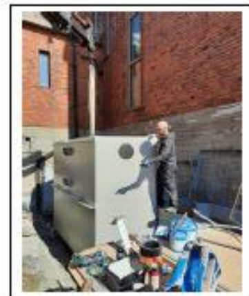
pyyntilaitteen runko asennettuna
